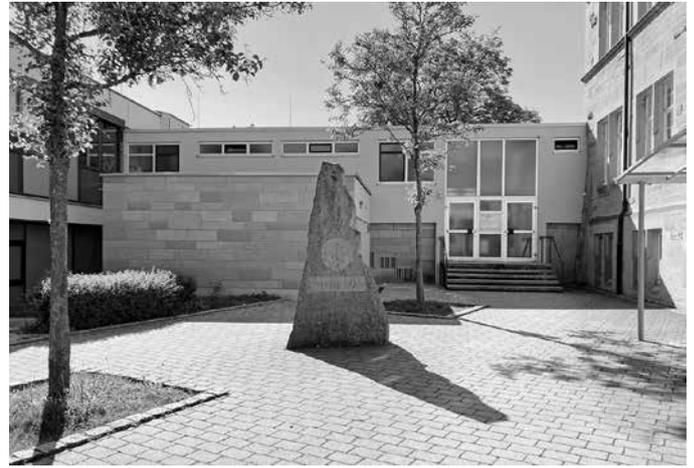
Die Umsetzung erfolgte in Holzbauweise direkt über dem Schwallwasserbehälter, der sich links vom Haupteingang des Bades befindet. So konnte auf eine neue Fundamentierung und Bodenplatte verzichtet werden. Der Anbau schließt an den bestehenden Technikraum an und bietet nun zusätzliche Lagerflächen für Salz, Reinigungsmittel, Filter, Chemiewannen und weiteres technisches Zubehör. Auf Anregung des Ortschaftsrates Mühlbach wurde ein barrierefreies, öffentlich zugängliches WC eingebaut.
