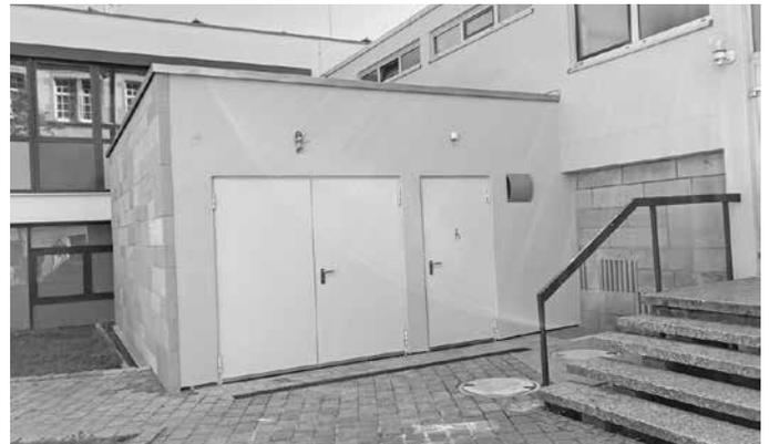
Um am wichtigen Dorfplatz dem dort allgegenwärtigen Sandstein gerecht zu werden wurde auf die äußere Gestaltung großer Wert gelegt. Der Anbau bekam eine Fassade aus Mühlbacher Sandstein, die sich zur Platzseite in die bestehende Umgebung einfügt. Die Schlussabrechnung des Projekts wird in einer der folgenden Sitzungen des Technischen Ausschuss vorgelegt.
