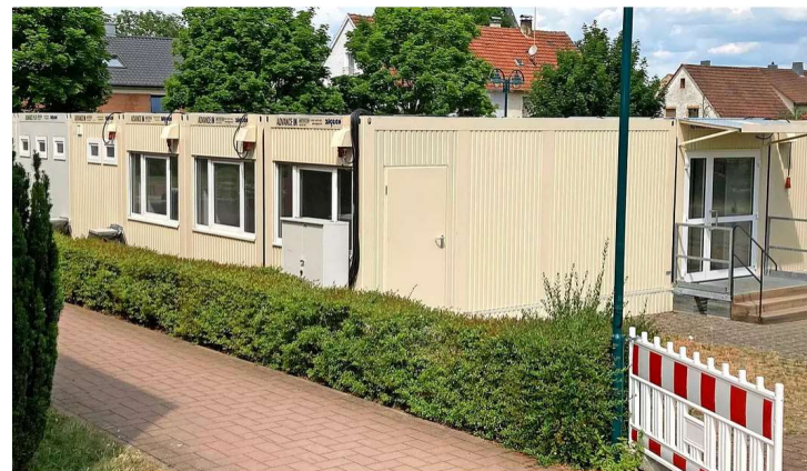
Von außen schlicht, aber zweckmäßig eingerichtet: In diesem Container-Behelfsbau sollen bis zu 20 Geflüchtete zeitweise ein neues Zuhause finden. Fotos: Jörg Kühl Foto: Kühl, Jörg
