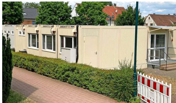
Von außen schlicht, aber zweckmäßig eingerichtet: In diesem Container-Behelfsbau sollen bis zu 20 Geflüchtete zeitweise ein neues Zuhause finden. Fotos: Jöra Kühl Foto: Kühl, Jöra
