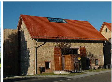
Abb. 55: Umbau einer Scheune in Boxberg
