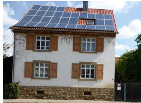
Abb. 23: Einfaches Wohnhaus, Adelshofer Straße 54
