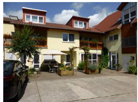
Abb. 43: Aktiv genutztes Nebengebäude, Adelshofer Straße 52: Ferienwohnungen
