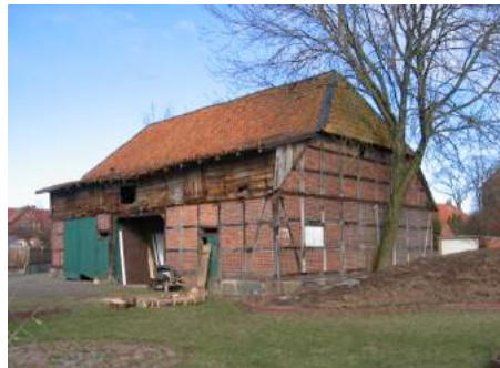
Abb. 52: Scheunengebäude vor Umnutzung, Bildquelle: http://www.dieplanschmiede.com
