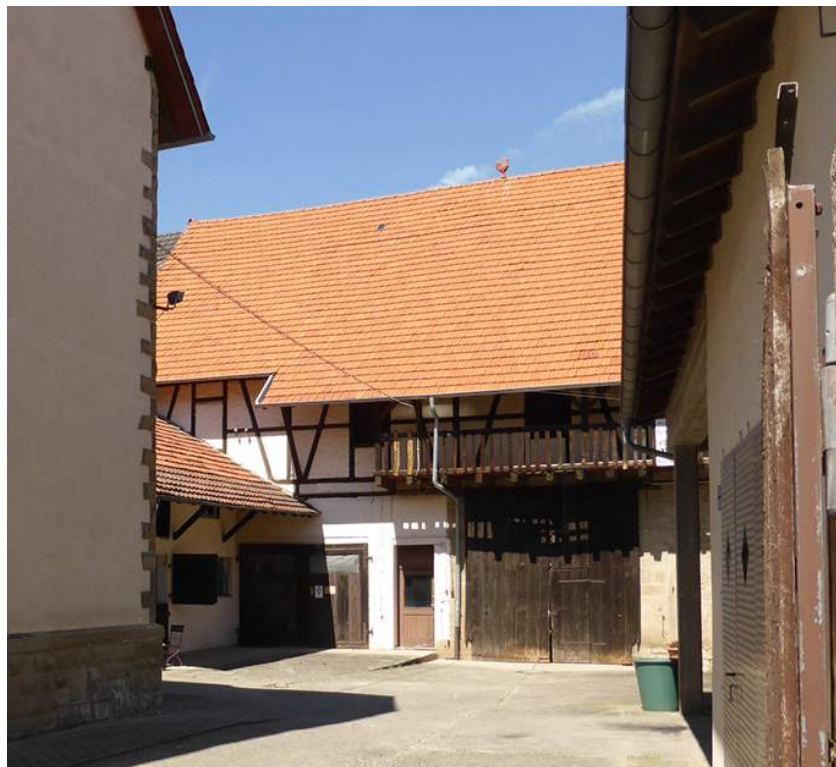
Abb. 27: Rückwärtiges Scheunengebäude mit Fachwerkkonstruktion
