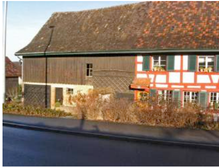
Abb. 56: Scheunengebäude vorher Bildquelle http://holzarchitektur.ch
