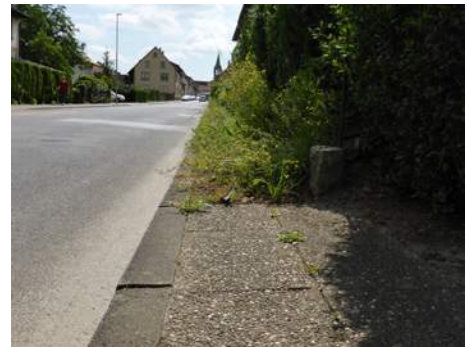
Abb. 31: Schmalen Gehweg entlang der Adelshofer Straße
