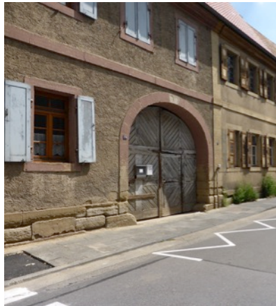
Sanierung von Gebäuden
