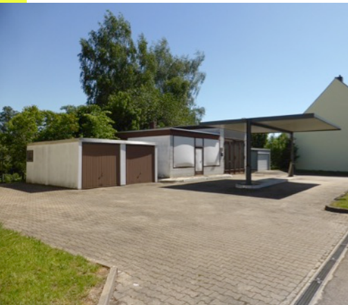
Reaktivierung von Leerständen
